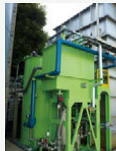
新設した加圧浮上槽（手前）
